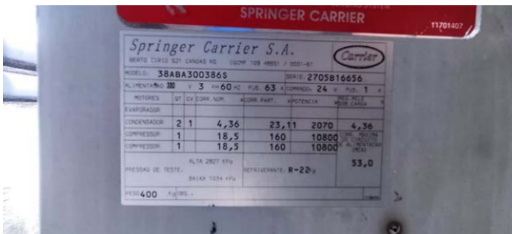
Foto: Placa de identificação do equipamento. Fonte: Betta, Instalação, Manutenção e Comércio LTDA.
